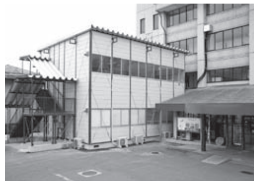
東館前仮設庁舎
