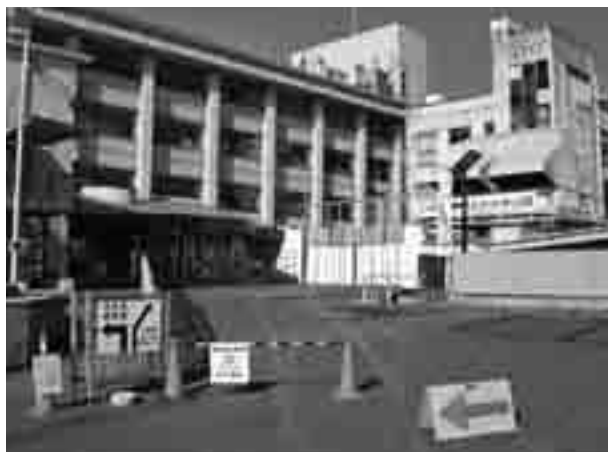
東館前バリケード・工事用ゲート
