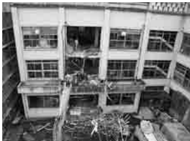
本館解体工事（9月2日現在）
