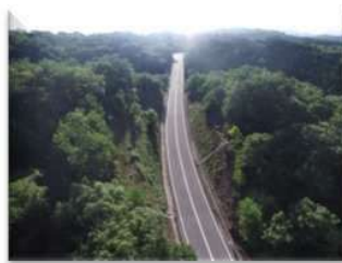
写真② 供用区間2
