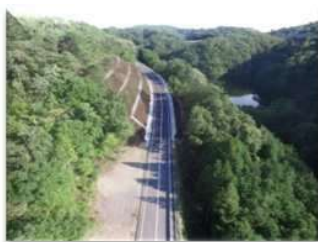
写真① 供用区間1
