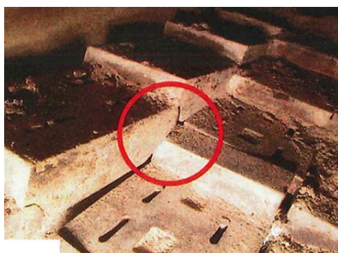
本市焼却炉内で発生した可動火格子の乗り上げ （三次市 平成 30 年 7 月豪雨災害廃棄物）
