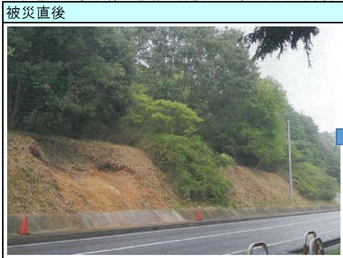
市道田口泉水線 道路災害復旧工事（三次市高杉町）
