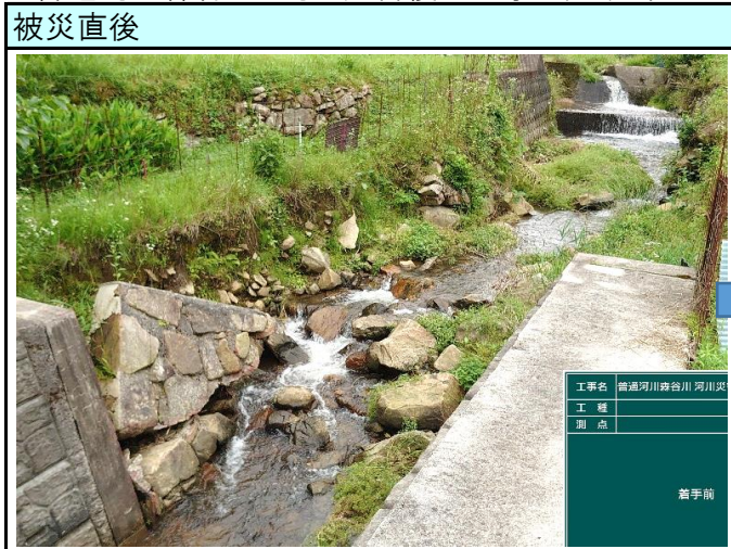
普通河川森谷川 河川災害復旧工事（三次市上田町）
