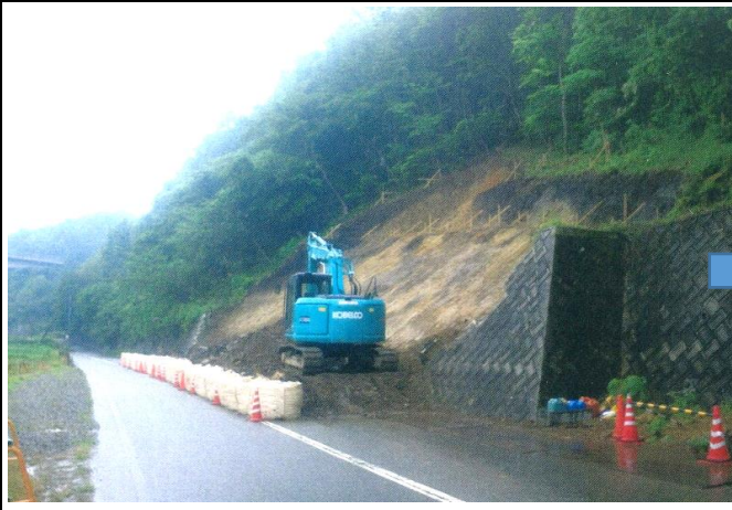
②復旧工事状況
