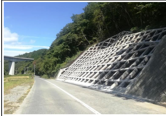
③復旧完了
