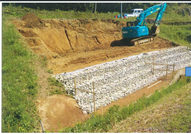
②復旧工事状況
