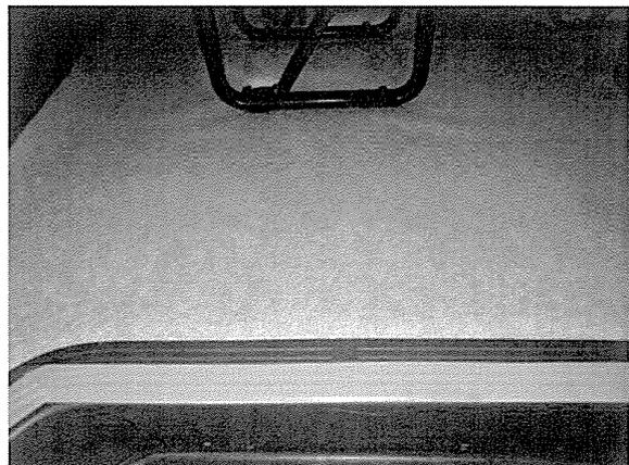
床面の材質:床面滑り防止素材(ゴムチップランナー)
