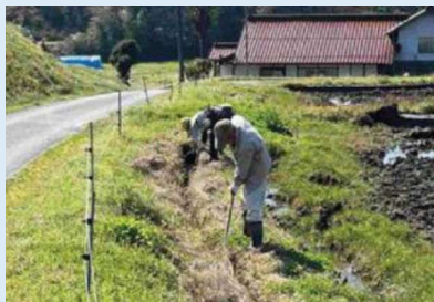
水路の泥上げ
