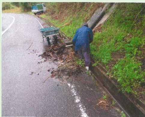
側溝清掃の様子
