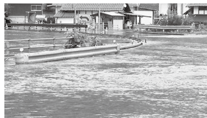
西日本豪雨 国道54号線冠水
