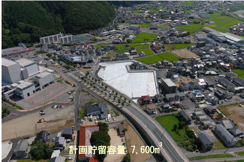
写真 2-1 五龍川貯留施設（権現川排水分区：令和4年8月完成）
