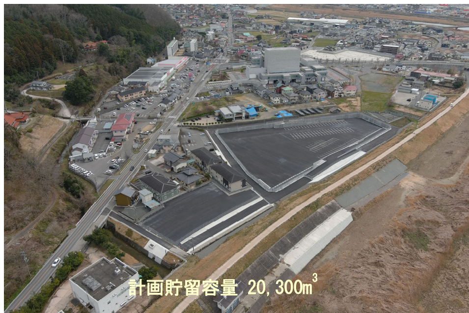
写真 2-2 権現川貯留施設（権現川排水分区：令和7年3月完成）
