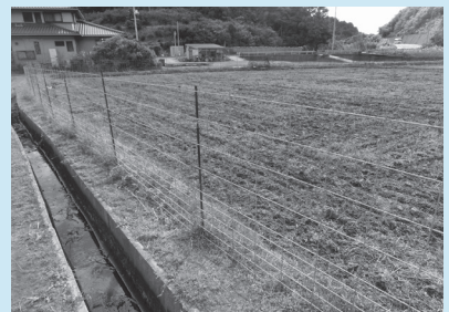
有害鳥獣対策(侵入防護柵)
