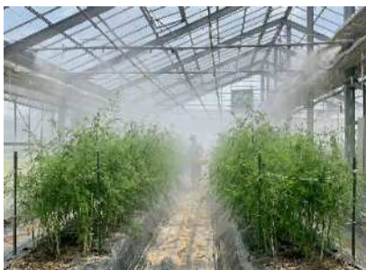
(細霧冷房システム)
