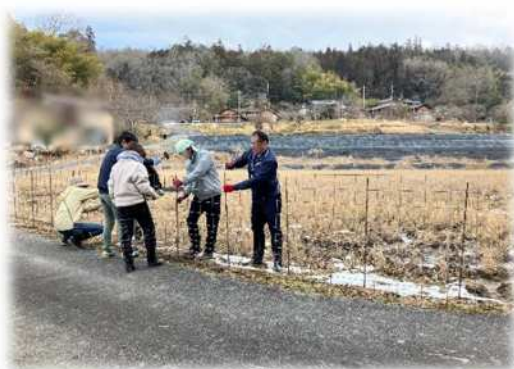
テゴスによる防護柵設置の支援
