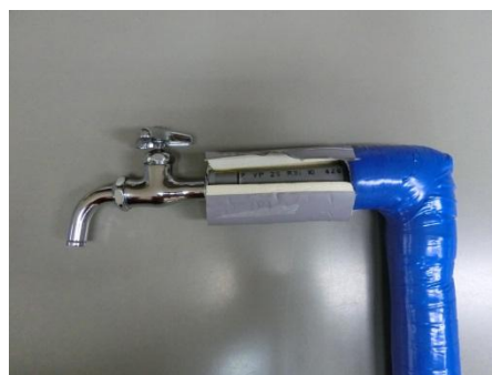
（保温材による水道管の保護）
