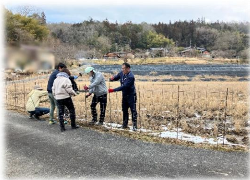
テゴスによる防護柵設置の支援
