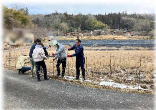
テゴスによる防護柵設置の支援
