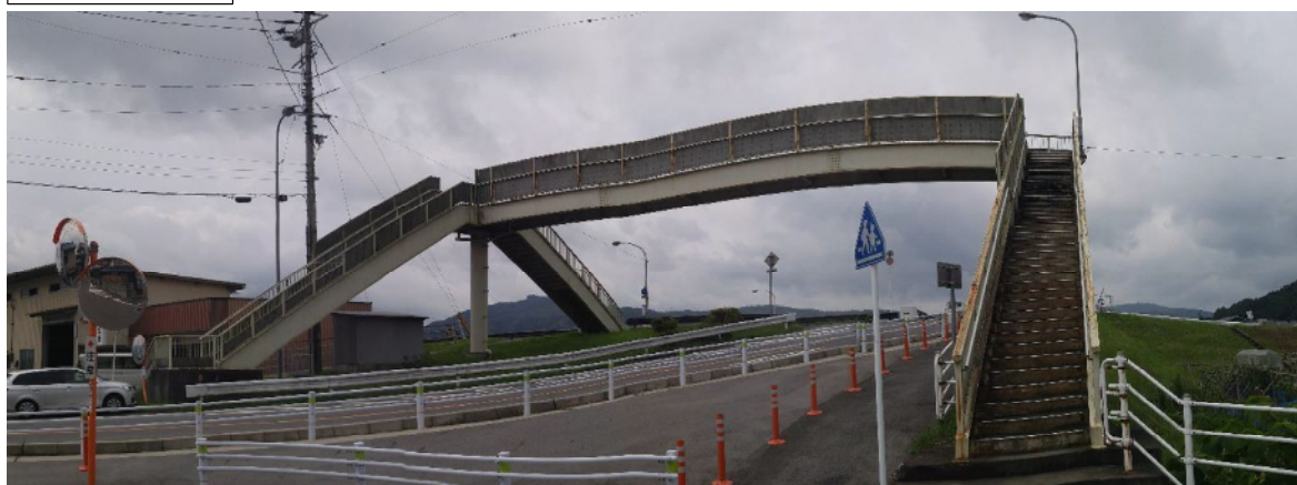
図 1-2 三谷市が管理する横断歩道橋
