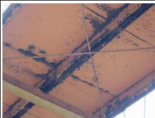
主桁の腐食・防食機能の劣化
