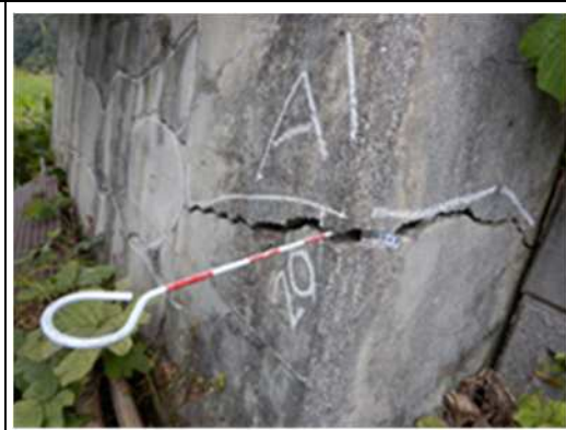
下部工のひび割れ
