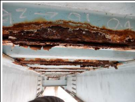
鋼床版の腐食・欠損
