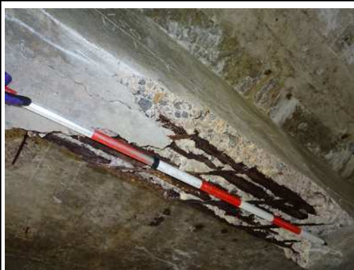
コンクリートのはく離・鉄筋露出・浮き
