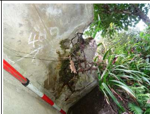
コンクリート床版の鉄筋露出
