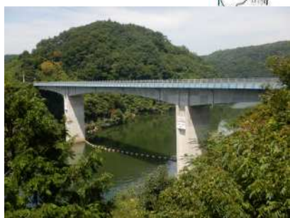
灰塚大橋 L=180.0m(PC橋) 2000年架設
