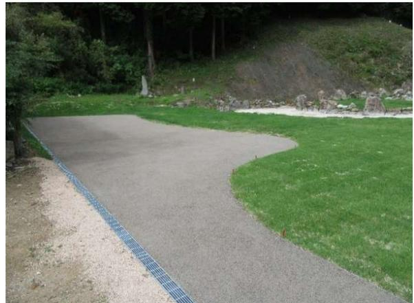
写真 5-8 スリット型側溝。側溝のフタを細い隙間状にしたもの（名勝常徳寺庭園…山口市）
