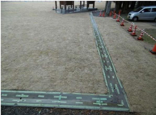
写真 5-7 コンクリート製のフタ（整備中の写真）
