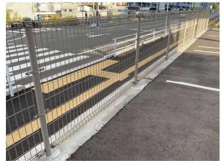
写真 5-11 転落防止柵の例（高さ 1.2m：エディオンピースウイング広島…広島市）
