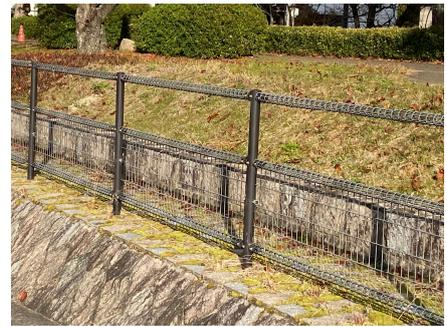
写真 5-10 転落防止柵の例（高さ 1.1 m：本川右岸…広島市）
