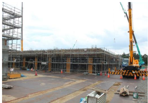
③ 消防本部・三次消防署 庁舎部分
