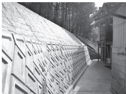
施工事例1：ブロック積+植生工
