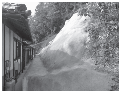
施工事例2：モルタル吹付
