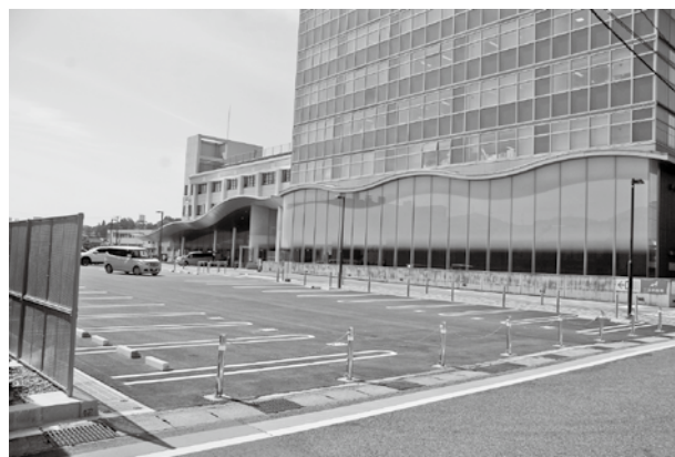
新たに整備された三次市役所駐車場
