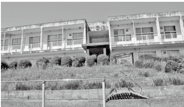
平成26年度末で廃校となった旧仁賀小学校
