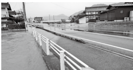
内水による道路冠水（川地地域）
