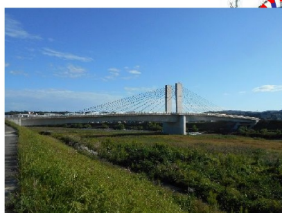
願橋 L=181.0m(PC橋) 2012年架設
