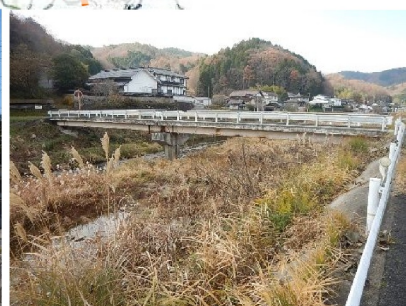
国広橋 L=37.1m(鋼橋) 1969年架設
