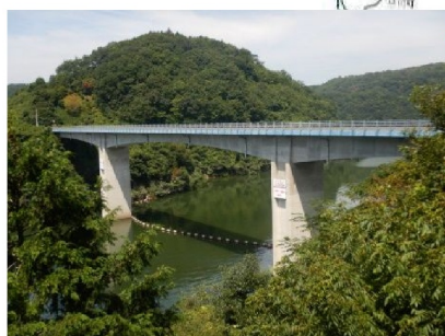
灰塚大橋 L=180.0m(PC橋) 2000年架設
