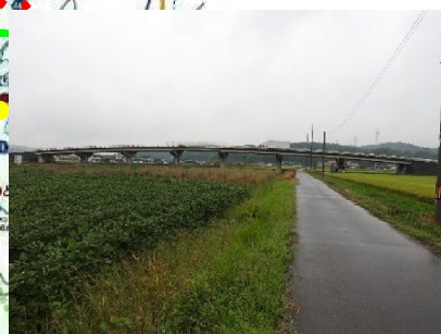
神杉跨線橋 L=138.0m(PC橋) 1981年架設
