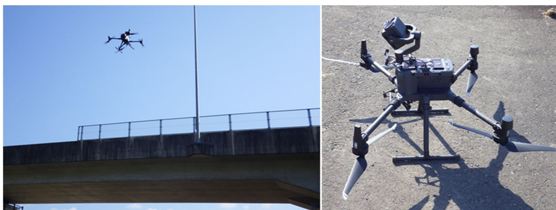
橋梁定期点検状況
