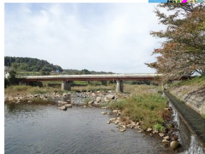
三ツ又橋 L=53.6m(鋼橋) 1973年架設
