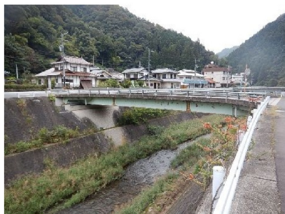
湊新橋 L=27.4m(鋼橋) 1987年架設
