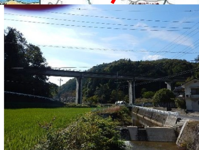
矢井大橋 L=160.0m(PC橋) 1994年架設
