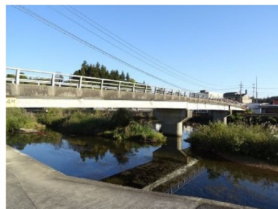
新記念橋 L=86.8m(PC橋) 1980年架設
