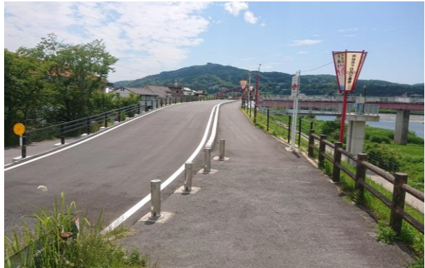
整備済み歩道の例（馬洗川堤防線）
