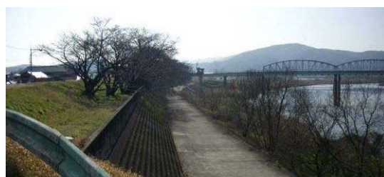
現在のコンクリート護岸
