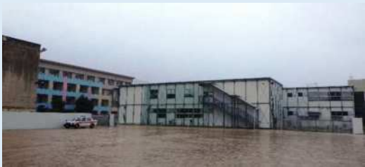
（三次小学校 仮設校舎）
