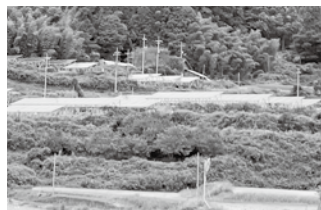
君田町茂田に設置されている太陽光パネル
