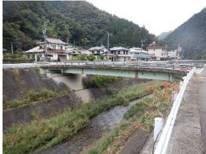
湊新橋 L=27.4m(鋼橋) 1987年架設
