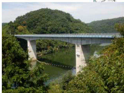
灰塚大橋 L=180.0m(PC橋) 2000年架設
