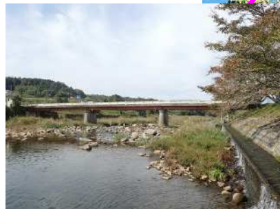
三ツ又橋 L=53.6m(鋼橋) 1973年架設
