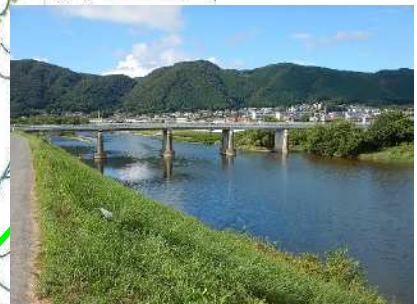
鳥居橋 L=214.6m(RC橋) 1938年架設
