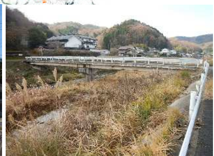
国広橋 L=37.1m(鋼橋) 1969年架設
