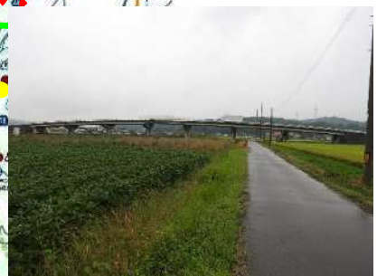
神杉跨線橋 L=138.0m(PC橋) 1981年架設
