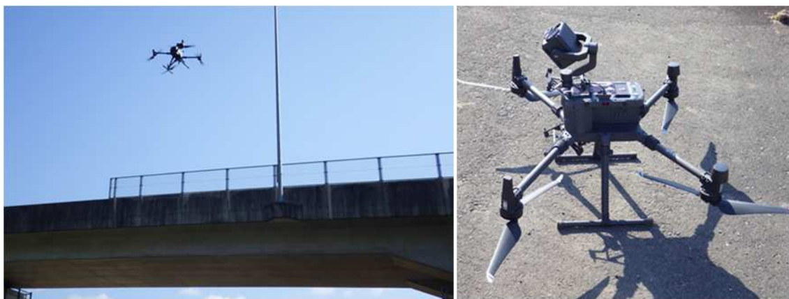
橋梁定期点検状況
