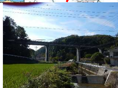
矢井大橋 L=160.0m(PC橋) 1994年架設
