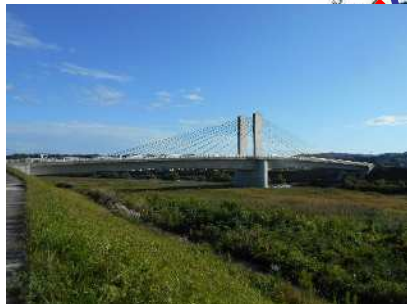
願橋 L=181.0m(PC橋) 2012年架設
