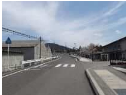
道路拡幅（市道宮森宮田線）
