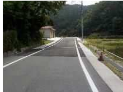
道路拡幅（市道徳市 553 号線）
