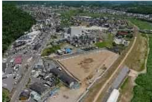
権現川貯留施設
