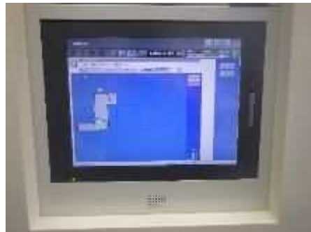
照明中央監視システム改修工事
