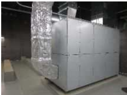
空調設備改修工事
