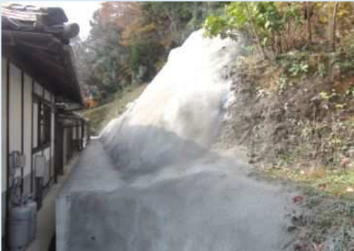
栗屋2地区 (モルタル吹付)
