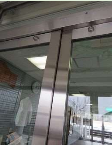
出入口扉の状況
