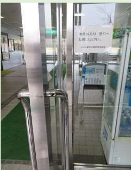
出入口扉の状況
