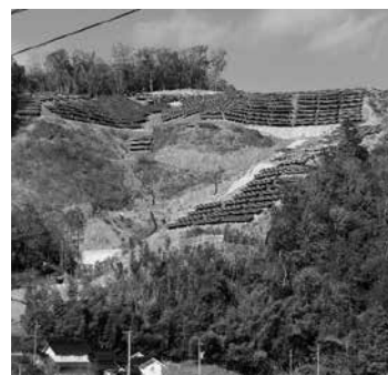
吉舎町檜地区の太陽光発電設備設置工事の箇所
