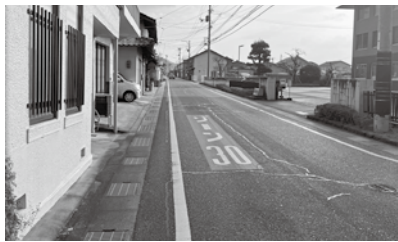
三次町内の県道「和知三次線」の未改良区間
