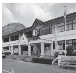
旧安田小学校校舎
