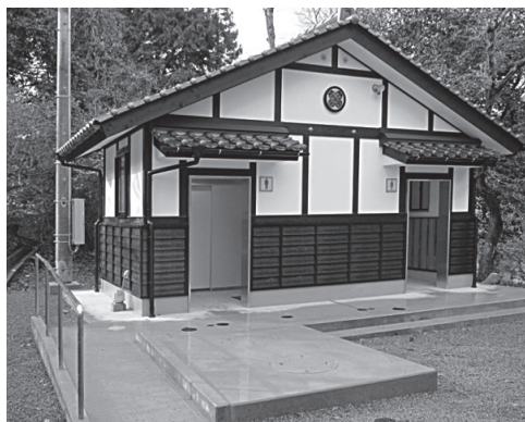
建て替えが完了した尾関山公園内の公衆トイレ
