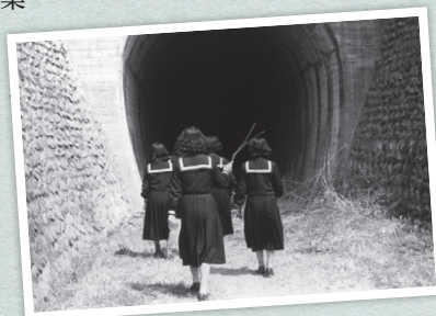
①レール敷設前の尾関山公園下のトンネル 昭和28年頃
