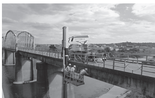
橋梁点検の状況
