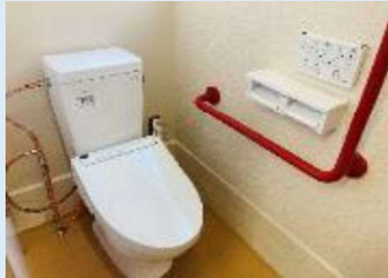
カーター記念球場トイレ改修状況
