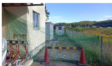
フェンス設置前
