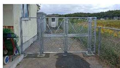
フェンス設置後
