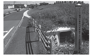
恵木谷川排水路 令和4年7月完成
