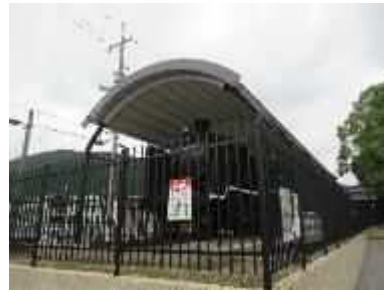
三次地区拠点施設 SL 展示場 屋根塗装工事
