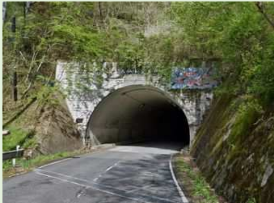
大仙トンネル入り口 (三次市側)
