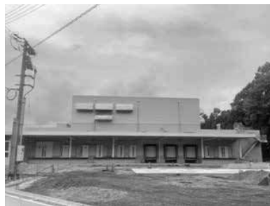
建設中の三次市新学校給食調理場 (6月現在)
