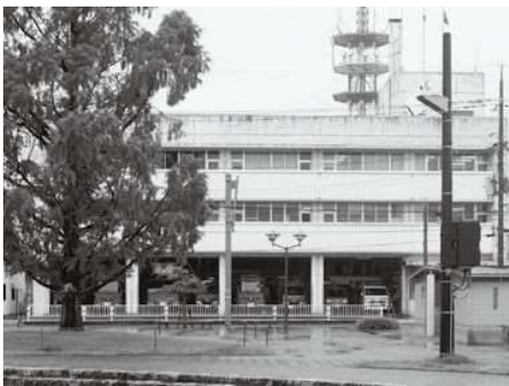
消防本部・三次消防署庁舎
