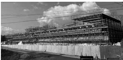
建設中の新学校給食センター（2月撮影）
