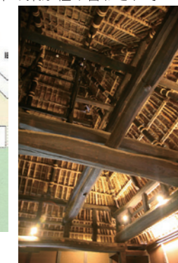
奥家住宅土間から見上げた屋根裏 (縦横に5本の梁が組み合わされている)
