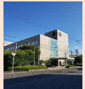
自治体クラウドデータセンター
