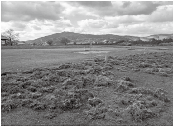
親水公園の被害状況
