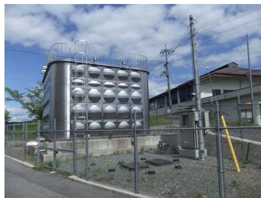
三和町敷名高区配水池電気設備
