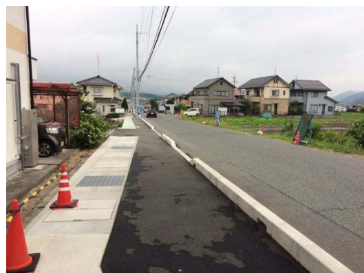
市道宮森宮田線（歩道整備）
