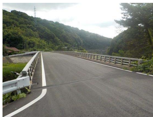
市道三良坂岡田線（浅浦橋） 橋梁長寿命化に基づく整備
