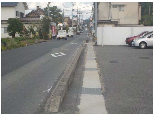
側溝蓋修繕による歩きやすい歩道整備 (市道十日市堂山線 南畑敷町)
