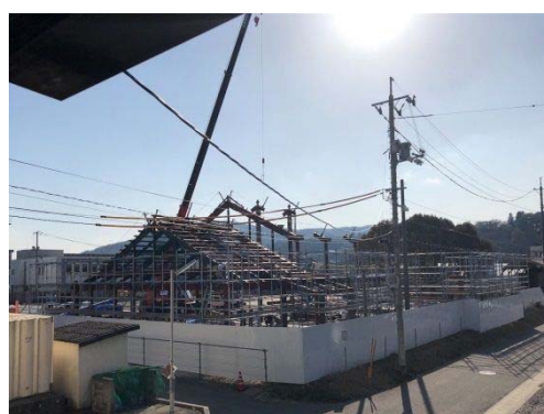
三次地区拠点施設建設状況 （平成30年3月14日現在）
